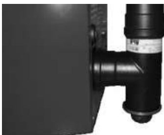
Fig. 66 - Fume conduit cleaning
